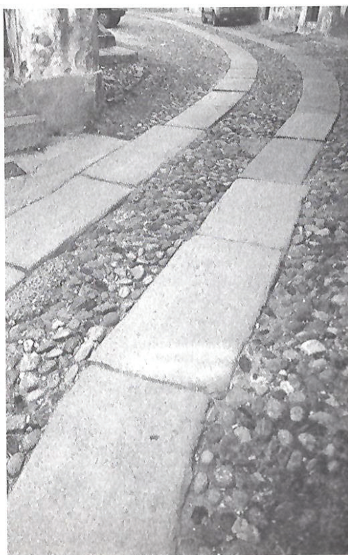
Fig. 12. Pavimentazione originaria in acciottolato con guide in Via Marconi, da conservare.
