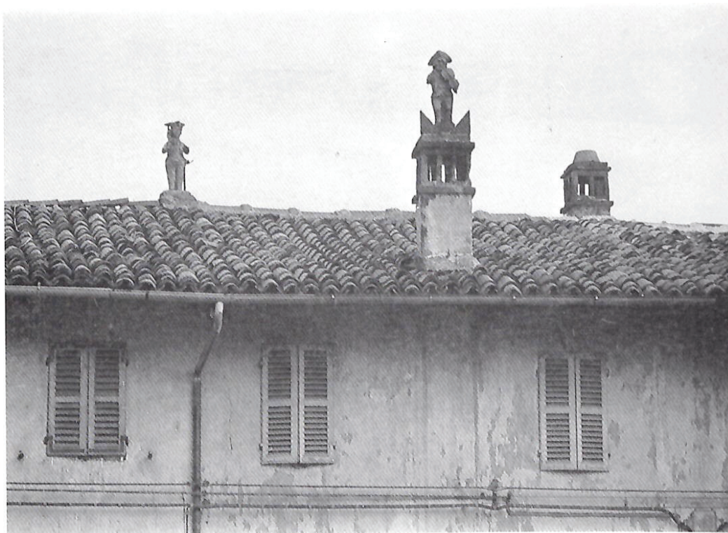
Fig. 10. Copertura originaria a coppi con i camini ornamentali in terracotta di Castellamonte in Via Marconi, da preservare.
