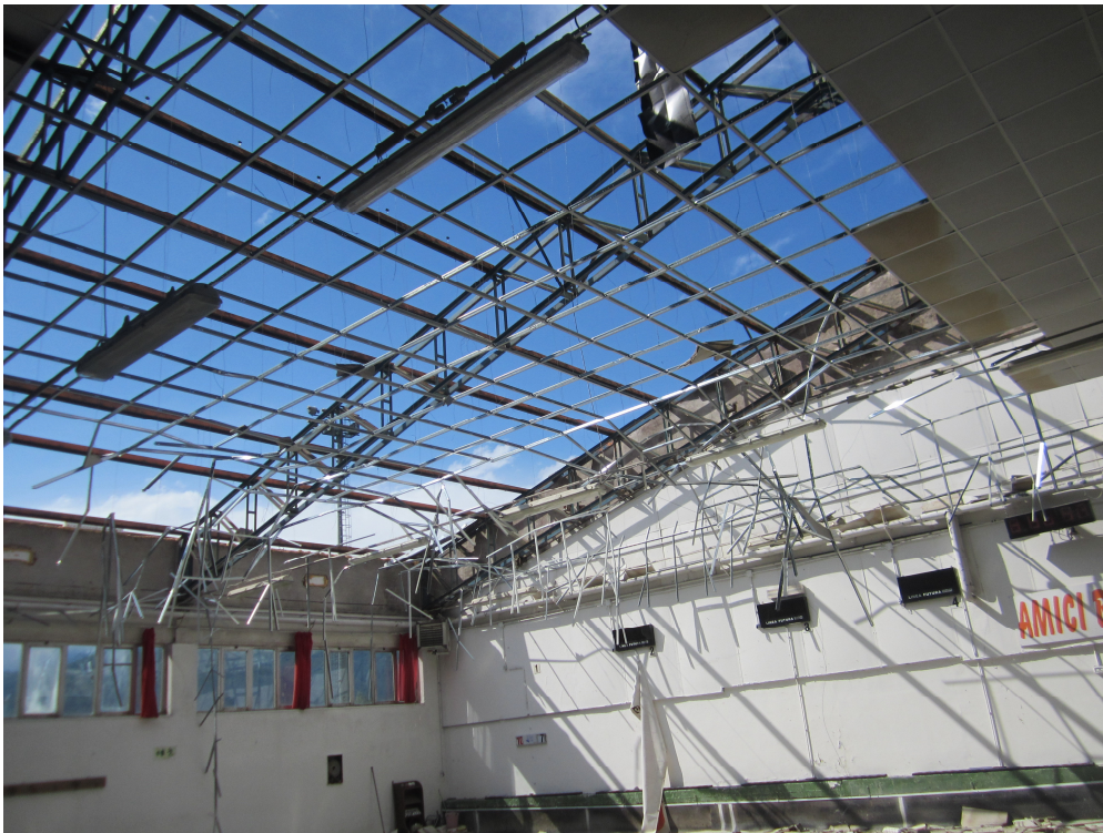
Foto n. 09. Vista dall'interno falda nord ovest scoperchiata
