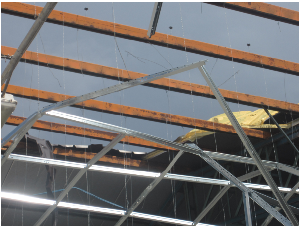
Foto n. 10. Dettaglio ancoraggi lastre divelti
