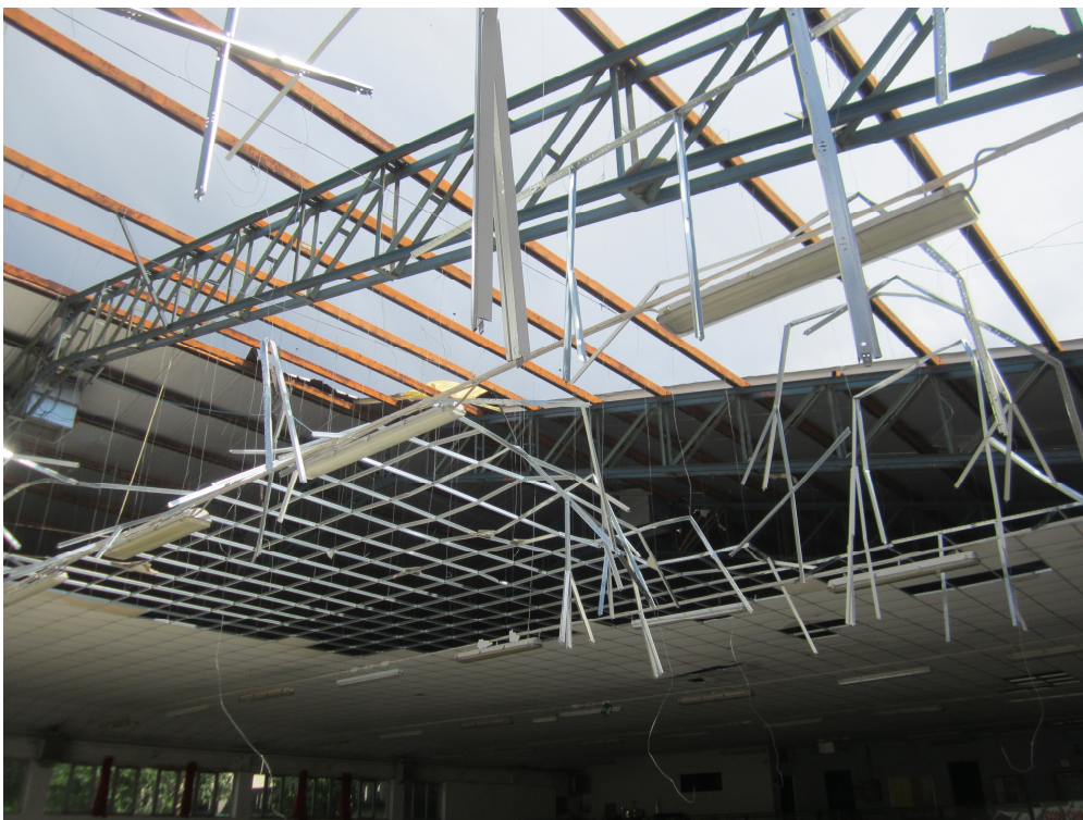
Foto n. 08. Vista dall'interno falda nord ovest scoperchiata
