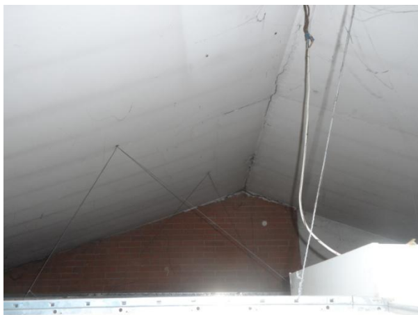
A falda inclinata, nelle zone di ingresso/atrio
